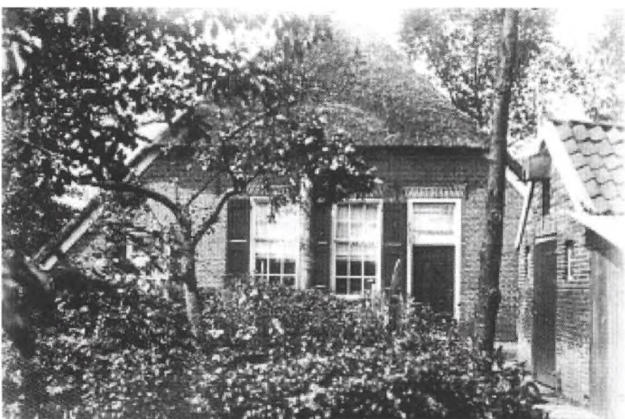
Welleweerd in Varsen. Rechts op de foto het kookhuis. Links tussen de bladeren is nog het raampje van het opkamer-tje te zien.
