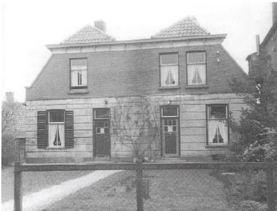
Dit dubbele woonhuis werd in 1900 gebouwd op de plek waar in 1864 Evert Woerink nog woonde. Ook zijn dochter Hendrika woonde er nog, met haar man Jan Schuttert. In 1950 maakten beide huizen plaats voor de Rabobank.
